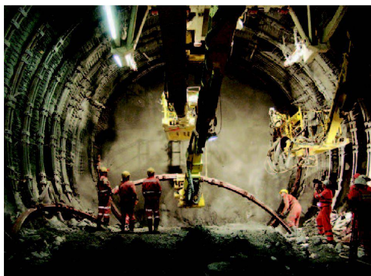
Abb. 6: Stahleinbau Sedrun.
