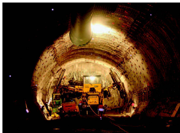
Abb. 7: Überfirstung Faido Weströhre.
