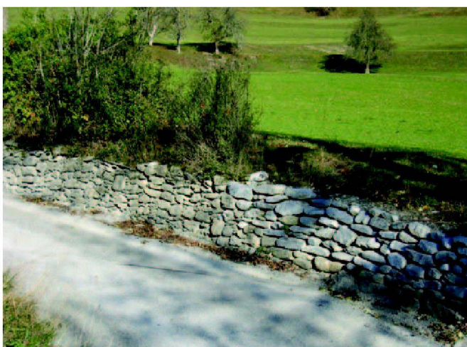
Abb. 9: Erneuerter Mauerabschnitt, der lokal eingepasst wurde und der genügend lang war, um den fehlenden Anzug zu konstruieren.
