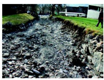
Abb. 4: Gleicher Strassenabschnitt wie in Abb. 3 von oben, am Tage nach dem Unwetter. Rechts ist der Rest der Trockenmauer sichtbar (grosser Findling im Mauerfuss). (Fotos 4, 7–10: R. Küntzel, Paspels.)
