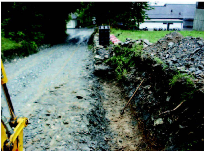
Abb. 7: Aushub des Fundaments für die Trockenmauer.
