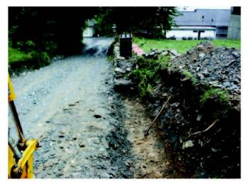
Abb. 7: Aushub des Fundaments für die Trockenmauer.
