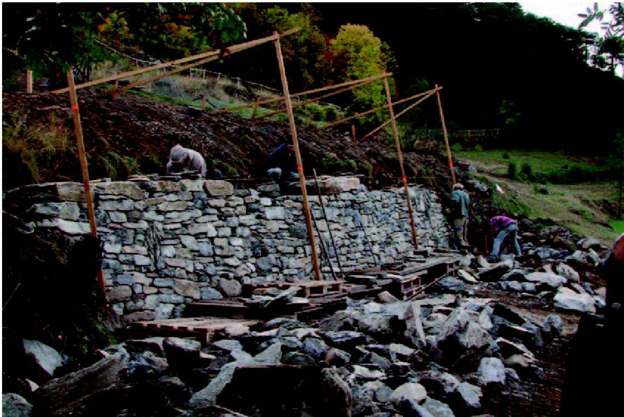
Abb. 3: Trockenmauer wird wieder aufgebaut.
