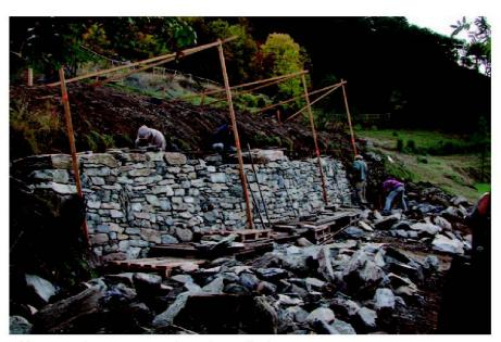
Abb. 3: Trockenmauer wird wieder aufgebaut.
