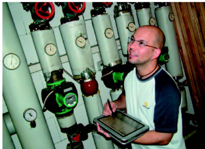
Mobiler Arbeitsplatz LIDS iView bei der Kellerbegehung.
