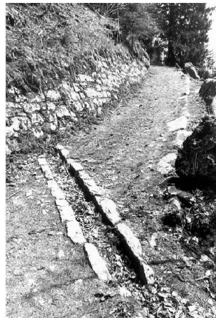
Abb. 1: Gemeinde Brienzwiler, vom Bund subventionierter Alpweg Wylervorsass, 2500 m lang, Ausführungskosten Fr. 18 200.-, ausgeführt 1896; heute historisches Objekt von nationaler Bedeutung (BE 162) wegen seiner überdurchschnittlichen Substanz.
