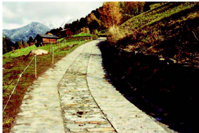
Abb. 4: Die Riedgasse am Albrunweg: eine Bicki wird wiederhergestellt.
