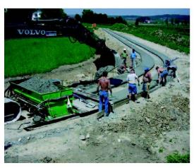
Abb. 4: Einbau Betonspuren im Bereich des Wildtierkorridors.
