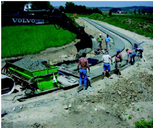
Abb. 4: Einbau Betonspuren im Bereich des Wildtierkorridors.
