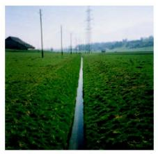
Abb. 1: Vor der Renaturierung: Schnurgerader Limpachkanal in einer Beton-Halbschale, steile Grasböschungen ohne jegliche Bestockung.
