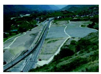
Fig. 6: Les matériaux d'excavation des tunnel CFF servent d'assise aux nouvelles voies pour la traversée d'une combe viticole.
