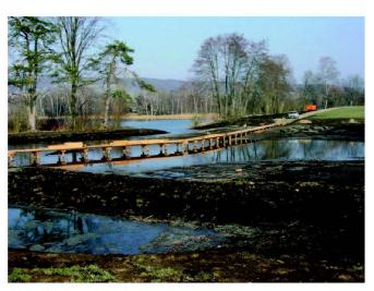
Abb. 5: Uferabflachung mit Fussgängersteg.
