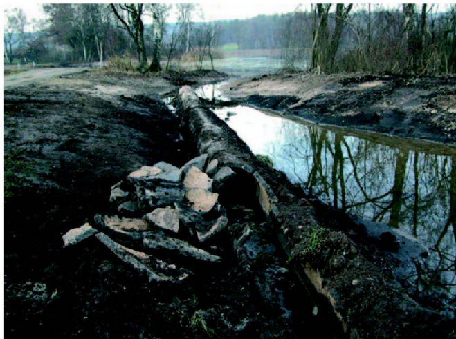
Abb. 4: Abbruch von Drainageröhren.
