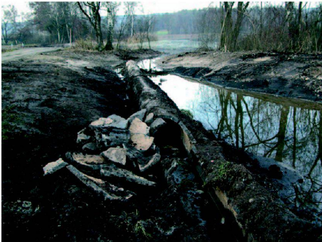
Abb. 4: Abbruch von Drainageröhren.
