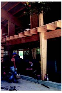
Fig. 3: Maracon VD: En peu de temps, les éléments préfabriqués en bois sont assemblés sur le chantier. Les finitions intérieures peuvent commencer immédiatement, réduisant d'autant la durée de construction.
