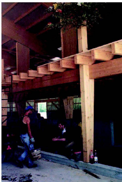
Fig. 3: Maraçon VD: En peu de temps, les éléments préfabriqués en bois sont assemblés sur le chantier. Les finitions intérieures peuvent commencer immédiatement, réduisant d'autant la durée de construction.
