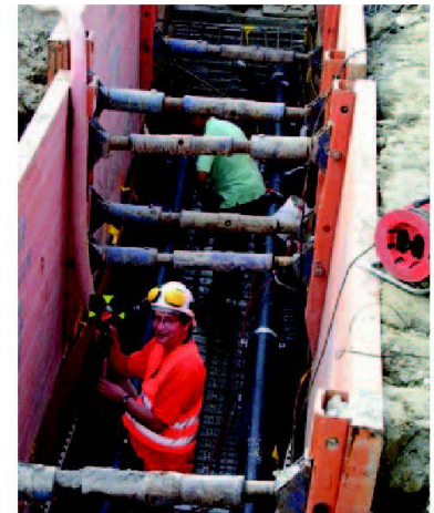
In Gräben: Immer Helm auf!
