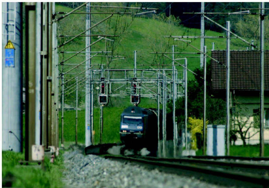
Abb. 1: Unterhalt und Betrieb von Bahnanlagen sind eine besondere Herausforderung. Mit KTU GIS erhalten Privatbahnen einen umfassenden Überblick über ihre Infrastrukturobjekte.
