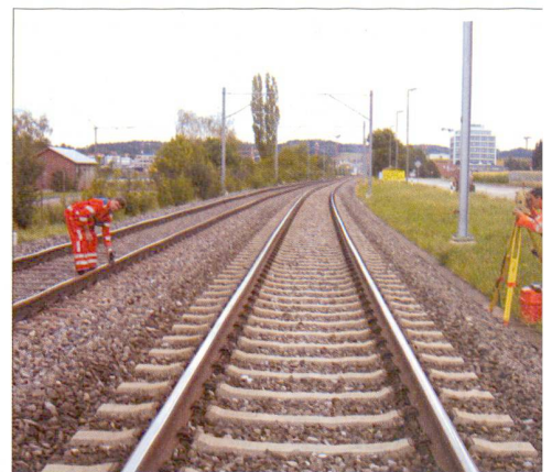
Abb. 6: Freie Stationierung, Kontrolle Gleislage.
