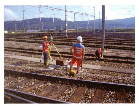
Abb. 1: Geomatikteam mit Sicherheitswärter bei Absteckungsarbeiten.
