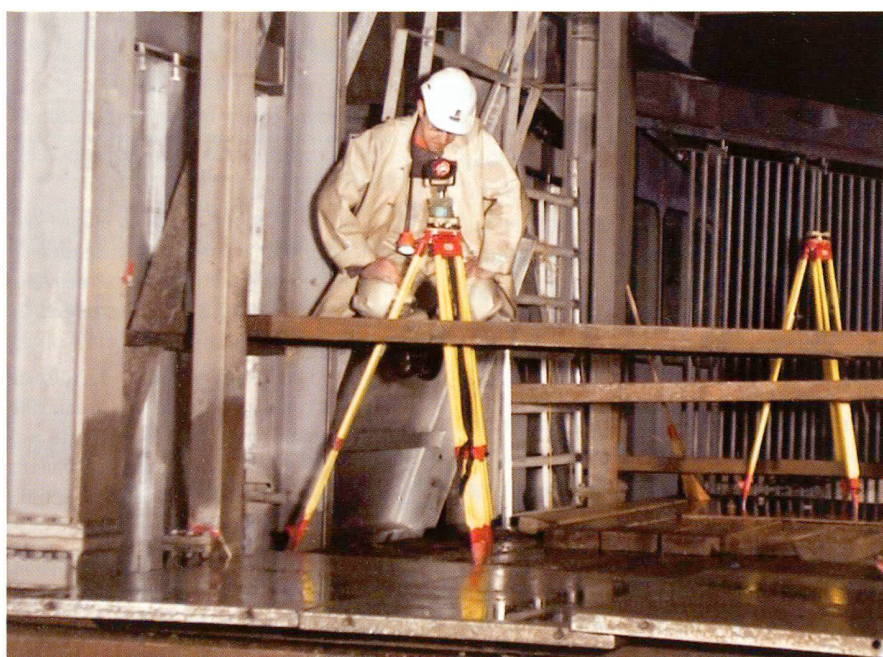
Abb. 2: Positionierung der Stative am Schachtfuss.
