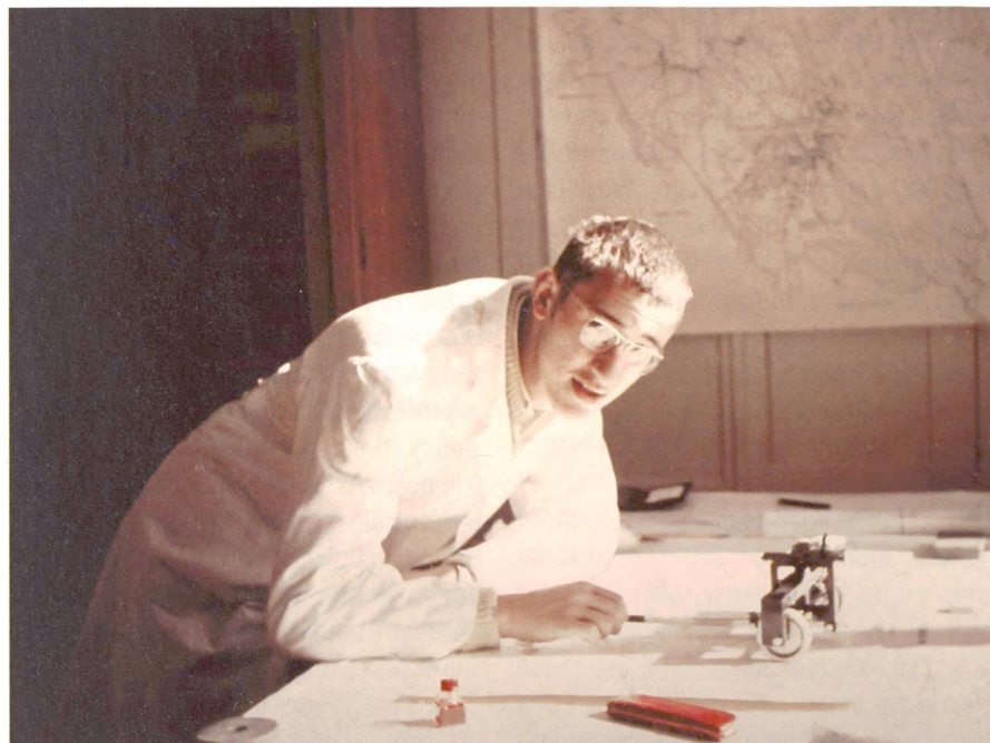
Abb. 1: So sah damals der Arbeitsplatz eines Vermessungszeichners aus. Es wurde oft stehend gearbeitet. Der blütenreine weisse Arbeitsmantel war Pflicht. Auf ein gepflegtes Auftreten wurde grossen Wert gelegt. Auf dem Tisch steht ein Coradi-Scheibenrollplanimeter. Dieser wurde zur Bestimmung von Flächeninhalten eingesetzt. Die Firma Gottlieb Coradi, Zürich, stellte nach hundert Jahren 1985 die Produktion ein (ebenso wie 1970 die Firma J. Amsler, Schaffhausen und 1990 die Firma A. Ott, Kempten).
