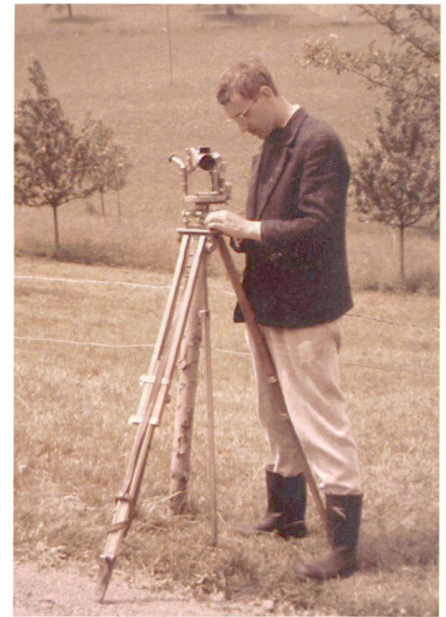
Abb. 3: Reduzierender Doppelbild-Tachymeter in einen Kontakt-Tachymeter der Firma KERN eingebaut. Solche Geräte standen noch bis anfangs der 60er-Jahre im Einsatz. Da kein optisches Lot vorhanden war, musste mit Senkblei oder Zentrierstock gearbeitet werden. Dieses Gerät wog 6,5 kg.
