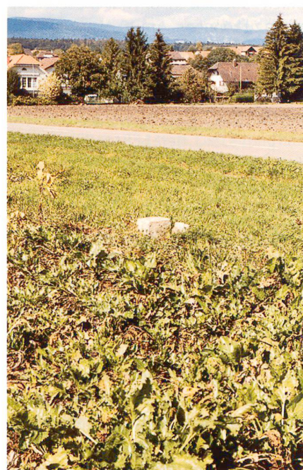
Abb. 8: Heutiger Zustand des Basisendes in Walperswil. Der sichtbare Granitstein wurde 1927 zusammen mit dem ursprünglichen Markierungsstein unter der Oberfläche in eine massive Betongrundplatte einbetoniert. Von den ursprünglich vier Versicherungssteinen (siehe Kontrollblatt Landestopografie) im Abstand von vier bis fünf Metern ist keiner mehr vorhanden, der letzte liegt hingeworfen an der Oberfläche.
