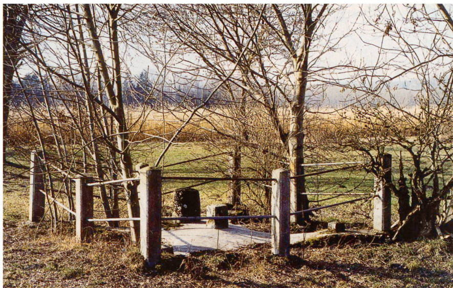
Abb. 7: Heutiger Zustand des Basisendes in Galmiz (Sugiez). Hauptsteine und Versicherungssteine (letzte mit einbetoniert) sind vorhanden und «im Blei». Das umliegende Terrain ist massiv abgesunken (schwarzer Torfboden), vor allem auch die vier mittleren Stützen der Einfriedung. Nicht beurteilbar ist die gesamte Absenkung nach der Juragewässerkorrektur in dieser Gegend. Sie könnte durchaus mehr als einen Meter betragen.
