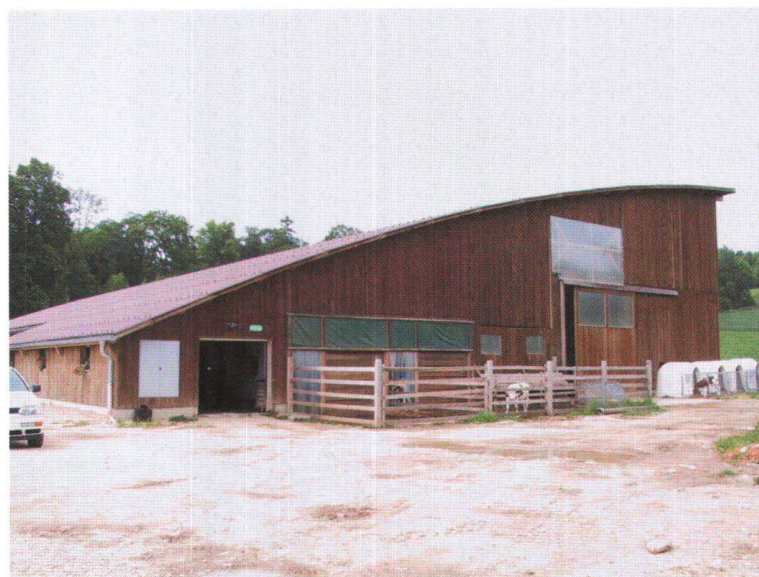
Abb. 9: Die neue Scheune für das Milchvieh der Betriebsgemeinschaft zweier Landwirte ist hoch beim Futterlager und niedrig im Stallteil. Mit dem optimalen Gebäudequerschnitt können Kosten gespart werden.
