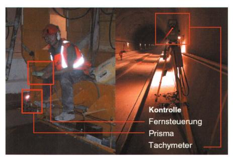
Abb. 6: Steuerung im Tunnel.
