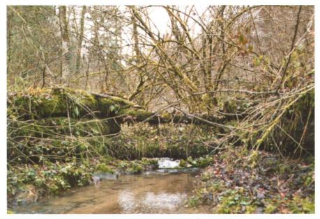
Abb. 2: Offene Sperre am Stutzgraben bei Osterfingen (Kanton Schaffhausen) bei Normalwasser. Durch die offene Holzsperre kann der Bach feineres Geschiebe weitertransportieren, wodurch eine minimale Bachdynamik möglich ist. Zudem ist die offene Sperre für aufwandernde Tiere passierbar.
