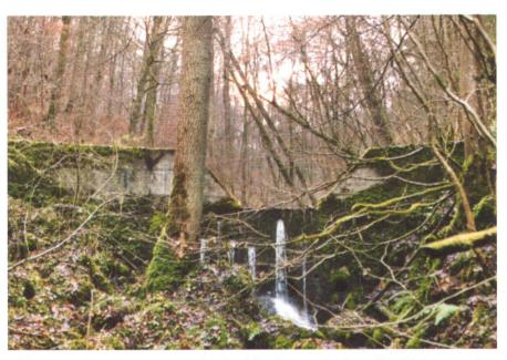
Abb. 1: Massive Betonsperre als Abschlussbauwerk eines Geschiebesammlers am Stutzgraben bei Osterfingen (Kanton Schaffhausen). Solche Geschiebesammler unterbinden jegliche Aufwanderung von Tieren und beeinträchtigen die Bachdynamik entscheidend.
