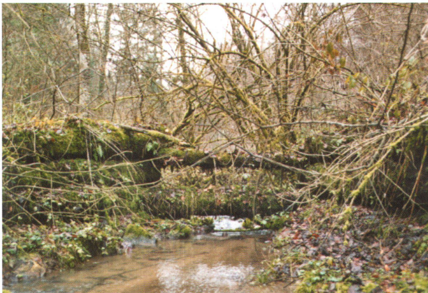
Abb. 2: Offene Sperre am Stutzgraben bei Osterfingen (Kanton Schaffhausen) bei Normalwasser. Durch die offene Holzsperrre kann der Bach feineres Geschiebe weitertransportieren, wodurch eine minimale Bachdynamik möglich ist. Zudem ist die offene Sperre für aufwandernde Tiere passierbar.
