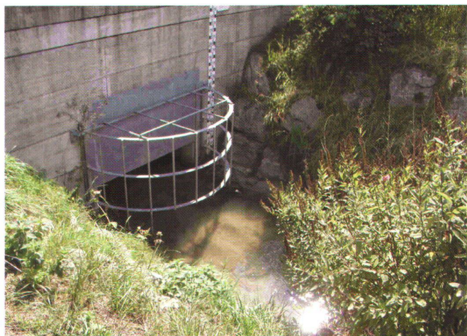
Abb. 2: Mit einem Polder-System wird das mögliche Hochwasser des «Chrouchtalbachs» zurückgehalten. Die Drosselung der Wassermenge erfolgt mittels Schiebern. Ein Grobrechen verhindert das Verstopfen der Schieberöffnung.
