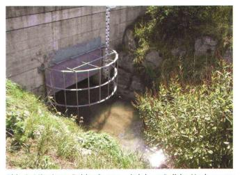
Abb. 2: Mit einem Polder-System wird das mögliche Hochwasser des «Chrouchtalbachs» zurückgehalten. Die Drosselung der Wassermenge erfolgt mittels Schiebern. Ein Grobrechen verhindert das Verstopfen der Schieberöffnung.
