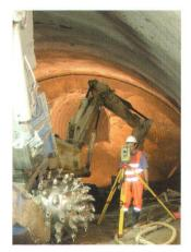
TMS PROFILE – Profilkontrolle im Tunnelvortrieb.
