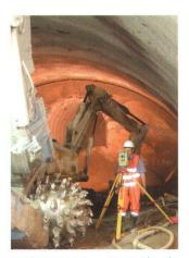
TMS PROFILE – Contrôle de profil durant le creusement.
