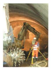
TMS PROFILE – Profilkontrolle im Tunnelvortrieb.
