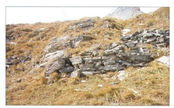
Abb. 6: Kleine Stützmauer des Weges an wenig schwieriger Stelle, letzter Überrest der künstlichen Bauten.
