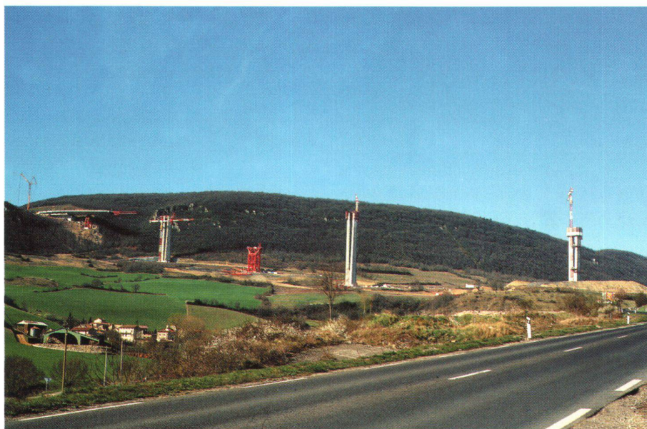
Abb. 2: Die verschieden hohen Brückenpfeiler sind in den oberen 90 Metern gabelförmig betoniert. Auf dem linken Bild schiebt sich von der südlichen Rampe bereits die erste Fahrbahn-Profilplatte Richtung Leererüst und Pfeiler P7. Ihre jeweilige Position und die gesamten Betonierarbeiten werden mit Leica GPS-Vermessungssystemen direkt eingemessen. Die vor Baubeginn fest installierte Referenzstation Leica GPS 530 RTK (Bild rechts) sendet für die differenzielle Messung im gesamten Baugelände rund um die Uhr Korrekturdaten aus. Dies ermöglicht es den Baufachleuten, mit ihren mobilen Leica GPS-Systemen die Betonverschalungen millimetergenau einzumessen. Foto: Leica Geosystems.
