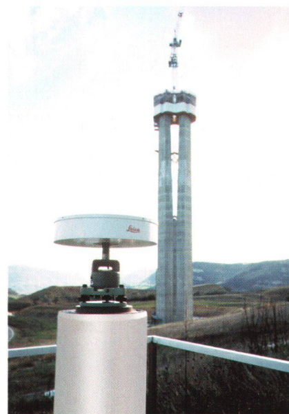
Abb. 2: Die verschieden hohen Brückenpfeiler sind in den oberen 90 Metern gabelförmig betoniert. Auf dem linken Bild schiebt sich von der südlichen Rampe bereits die erste Fahrbahn-Profilplatte Richtung Leererüst und Pfeiler P7. Ihre jeweilige Position und die gesamten Betonierarbeiten werden mit Leica GPS-Vermessungssystemen direkt eingemessen. Die vor Baubeginn fest installierte Referenzstation Leica GPS 530 RTK (Bild rechts) sendet für die differenzielle Messung im gesamten Baugelände rund um die Uhr Korrekturdaten aus. Dies ermöglicht es den Baufachleuten, mit ihren mobilen Leica GPS-Systemen die Betonverschalungen millimetergenau einzumessen. Foto: Leica Geosystems.
