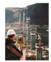
Abb. 1: Der Bau der höchsten Brücke der Welt und der gleichzeitig weltweit längsten Mehrpfeiler-Schrägseilbrücke im Tal des Tarn in Südwestfrankreich ist eine ingenieurtechnische Herausforderung. Mit den genauesten Vermessungssystemen von Leica Geosystems wird der Baufortschritt von Vermessungschef Pierre Nottin und seinen vier Fachkollegen laufend überwacht. In die Betonpfeiler sind kleine Optik-Präzisionsreflektoren zur automatisierten Bauwerkkontrolle eingegossen. Foto: Leica Geosystems.
