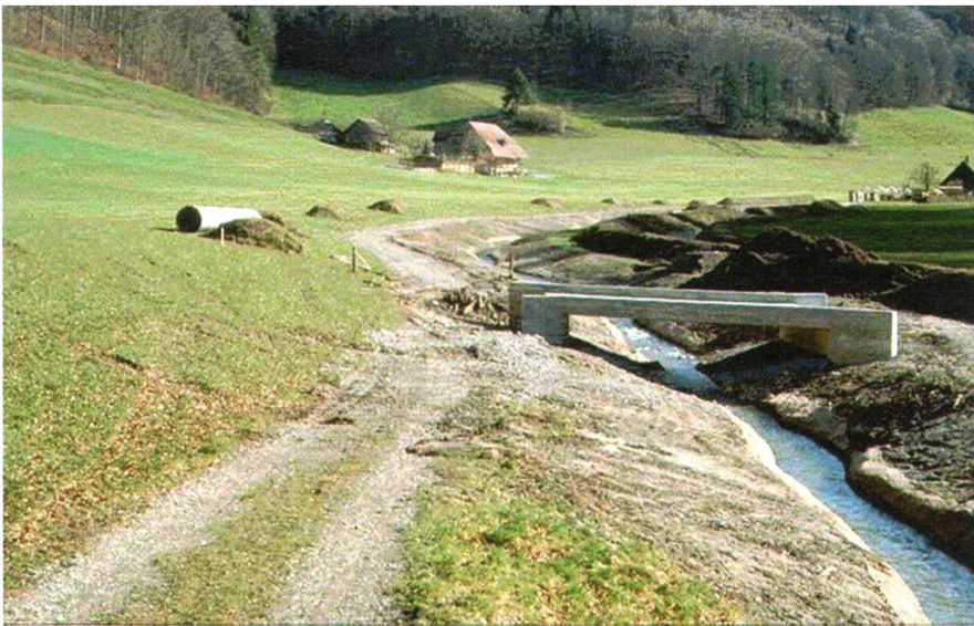
Abb. 3: Multifunktionale Meliorationsmassnahmen: Hochwasserschutz, Bachrenaturierung und Erschliessung für eine rationelle landwirtschaftliche Bewirtschaftung in der Gesamtmelioration Krauchthal (BE). Wer hat welchen Nutzenanteil?
