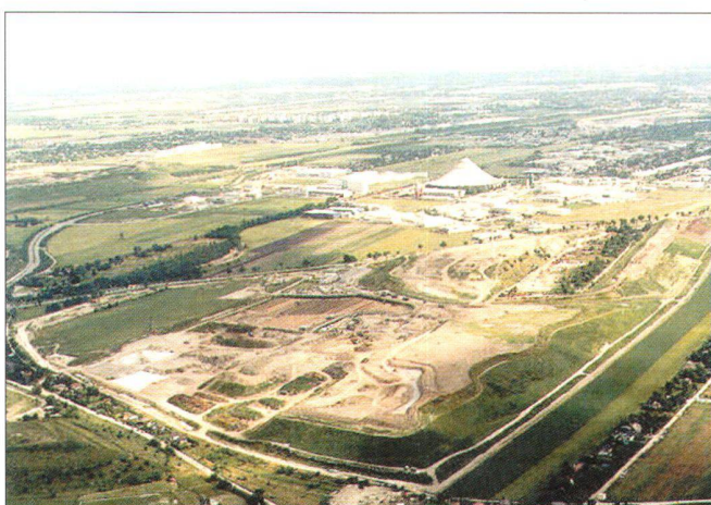
Abb. 5: Langes Feld: Geländemodellierung und Vererdungsanlage mit Hitzerottenwällen (braun in Bildmitte).
