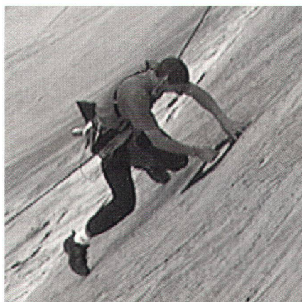
Abb. 2: Anbringen der Zielmarken an der Staumauer.
