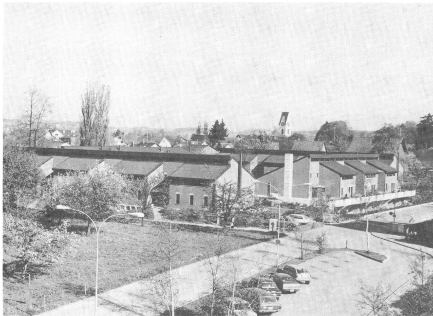
Fig. 4: Quartier d'habitations selon le principe de l'habitat groupé (Photos: Fondation Suisse pour la protection et l'aménagement du paysage).
