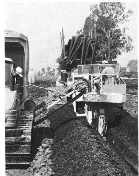
Abb. 4 Draingrabenfräsmaschine im Einsatz
