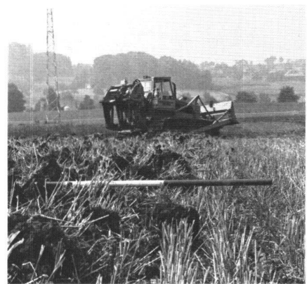
Abb. 7 Primärauflockerung ergibt eine Zunahme des Porenvolumens von 20–30%
