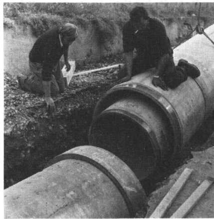
Abb. 2 Das Verbinden der Doppelrohre im Graben. Die Konzentrität der beiden Rohre in der Einbaulage wird durch zwei Auflagerplatten gewährleistet, die an der Kupplung des Innenrohres angebracht sind.
