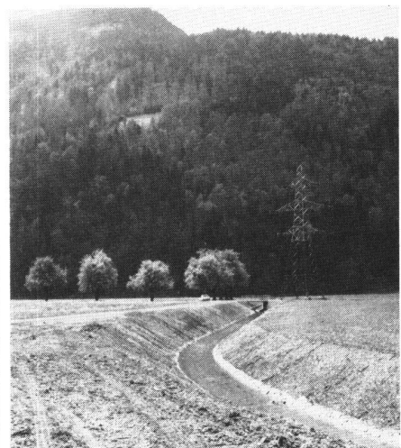
Abb. 3. Der neu ausgebaute Saschielbach
