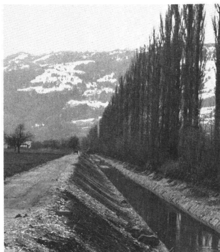
Abb. 2. Der vertiefte und verbreiterte Saarkanal. Kiessohle und Natursteinpflasterung unter Schonung des linksufrigen Pappelbestandes. Neuer Parallelweg. Rechts im Bild erkennt man noch die alte Pflasterung mit kleinen Steinen und damit die Tiefe des alten Kanals. Zustand 1970
