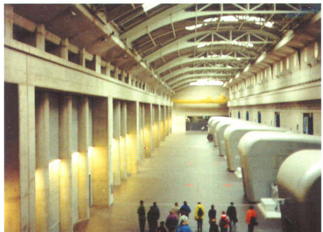
Abb. 2: Maschinenhalle des Kraftwerkes Freudenau (Foto: U. Meier).
