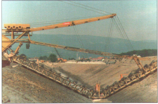
Abb. 8: Aushub des Seebodenkanals, Gampelen, Eimer- kettenbagger, 1976.
