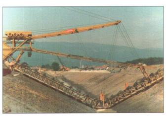
Abb. 8: Aushub des Seebodenkanals, Gampelen, Eimerkettenbagger, 1976.
