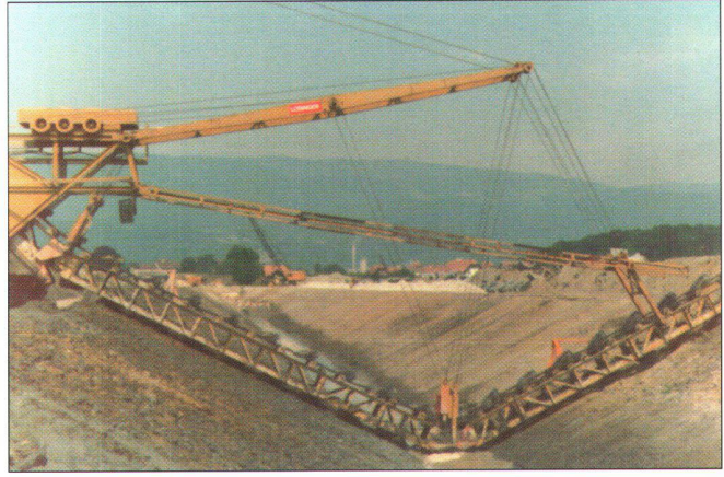
Abb. 8: Aushub des Seebodenkanals, Gampelen, Eimer- kettenbagger, 1976.
