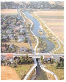
Abb. 1: Der Marchfeldkanal bei Stammersdorf Fliessrichtung nach Norden (im Bild nach oben). Der Begleitweg und die angepasste Gerinneführung mit Inseln, verschiedenen Uferarten sowie die nötigen Bauwerke zeigen, dass für Flora und Fauna sowie für Freizeit- und Erholung die nötigen Voraussetzungen geschaffen wurden.
