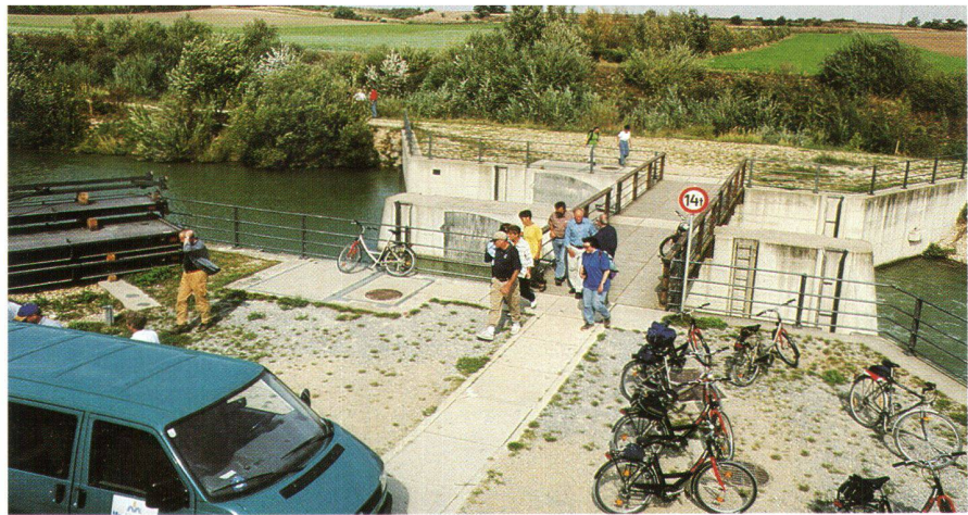
Abb. 4: Wehr bei Stammersdorf. Die Wehr- und Verschlussorgane sowie Pumpwerke werden über ein zentrales Leitsystem vom Betriebshof Deutsch-Wagram aus gesteuert. Links im Bild das Reserveabsperrmaterial, das im Störfall von Hand eingeschoben werden muss. Dank dem durchgehenden Begleitweg können alle Anlagen mit dem Rad oder zu Fuss besichtigt werden.
