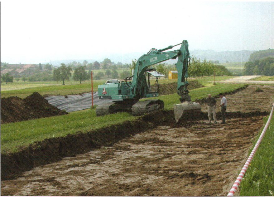
Abb. 1: Ein perfekter Baustreifen mit dem Humus- und Unterbodendepot, dem noch freien Streifen für den Grabenaushub und dem eigentlichen Grabenbereich (von links nach rechts). Rechts im Bild folgt die Kiespiste (nicht sichtbar). Der Bagger ist mit breitem Fahrwerk und einem Schwenklöffel ausgerüstet (Foto M. Achermann).
