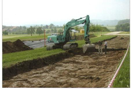
Abb. 1: Ein perfekter Baustreifen mit dem Humus- und Unterbodendepot, dem noch freien Streifen für den Grabenaushub und dem eigentlichen Grabenbereich (von links nach rechts). Rechts im Bild folgt die Kiespiste (nicht sichtbar). Der Bagger ist mit breitem Fahrwerk und einem Schwenklöffel ausgerüstet (Foto M. Achermann).
