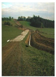
Abb. 2: Die 50 cm mächtige Kiespiste kommt auf beinahe allen Böden zum Einsatz. Nur auf sehr schnell abtrocknenden und besonders tragfähigen Böden wird keine Piste geschüttet, dort wird direkt auf der Grasnarbe gefahren (Foto M. Achermann).
