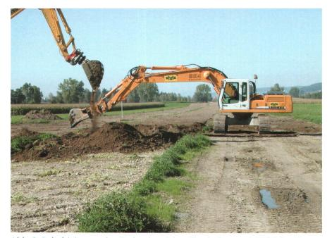
Abb. 3: Rekultivierung des Grabenbereiches. Der lockere, schüttfähige Humus wird mit zwei Bagger eingebracht. Die Maschinen stehen auf Baggermatratzen weil der Unterboden nach einem Niederschlag noch feucht ist. Sofern alle Erdarbeiten bei guten Bedingungen ausgeführt werden konnten, ist ein Vorbegrünen des eingebrachten Unterbodens nicht notwendig (Foto M. Achermann).
