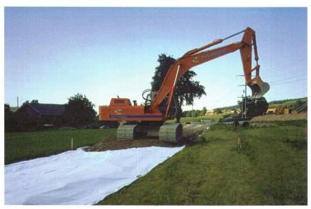
Abb. 1: Anlegen der Kiespiste mit dem Bagger, Schütten vor Kopf auf ein Geotextil, welches direkt auf die zurückgeschnittene Grasnarbe gelegt wird. Die Kiespiste dient für alle folgenden Transporte, das Biegen, das Schweissen und das Absenken der Rohre (Foto M. Achermann).
