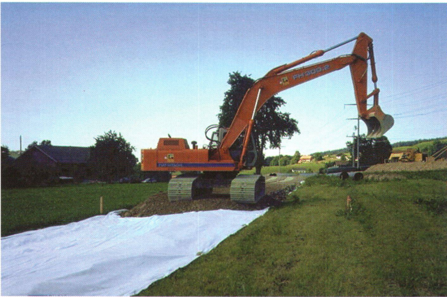
Abb. 1: Anlegen der Kiespiste mit dem Bagger, Schütten vor Kopf auf ein Geotextil, welches direkt auf die zurückgeschnittene Grasnarbe gelegt wird. Die Kiespiste dient für alle folgenden Transporte, das Biegen, das Schweißen und das Absenken der Rohre (Foto M. Achermann).
