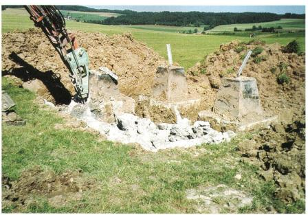
Abb. 2: Abbruch eines Trägermastens: Separierung Ober- und Unterboden, Abbruch des Betonsockels.
