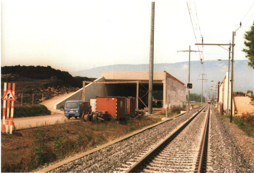
Abb. 1: Wildüberführung Islerenhölzli in Gampelen über T10 und Bahn im Bau. Kombinierte Ökomassnahme beim Bau der Umfahrung Ins-Gampelen. Die Aufschüttung für die Wild-Querung besteht aus schwermetallverseuchtem Bodenmaterial.
