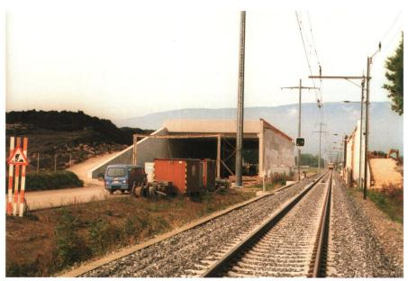
Abb. 1: Wildüberführung Islerenhölzli in Gampelen über T10 und Bahn im Bau. Kombinierte Ökomassnahme beim Bau der Umfahrung Ins-Gampelen. Die Aufschüttung für die Wild-Querung besteht aus schwermetallverseuchtem Bodenmaterial.
