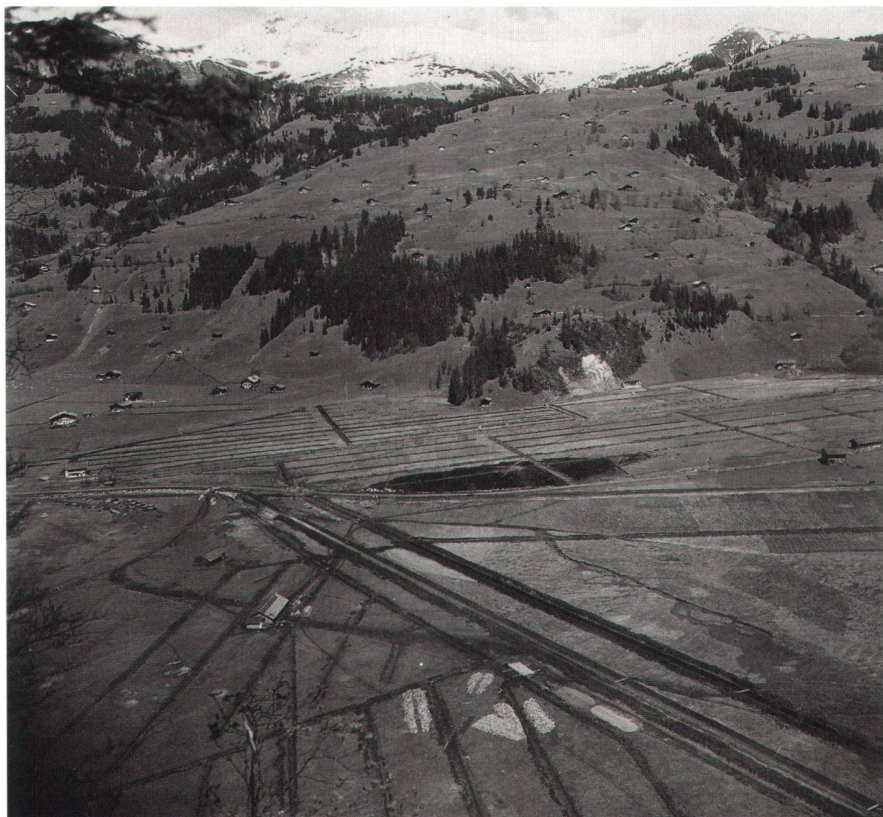
Abb. 1: Grossflächige Entsumpfungsarbeiten an der Lenk 1921–1924 zwecks Gewinnung von Kulturland (Fotos: ASV BE).
