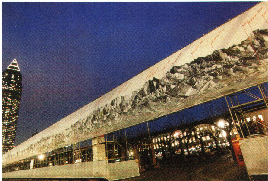
Abb. 12: Das fertige DIGIRAMA am Gerüst.
