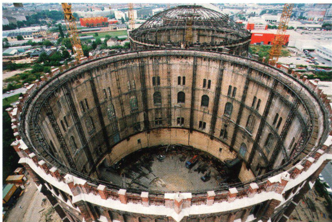
Abb. 3: Gasometer C und D in unterschiedlichen Renovationsstadien. Foto: Porr/Rappersberger.
