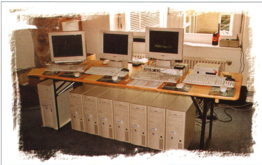
Abb. 4: Moderne Installationsroutinen durch Klonvorgänge für schlüsselfertige EDV-Komplettlösung. GU-Mandat v. Fischer & Cie AG, Bern (Liegenschafts-, Vermögens- und Immobilienverwaltung) und v. Fischer Gukelberger (Advokatur und Notariat).
