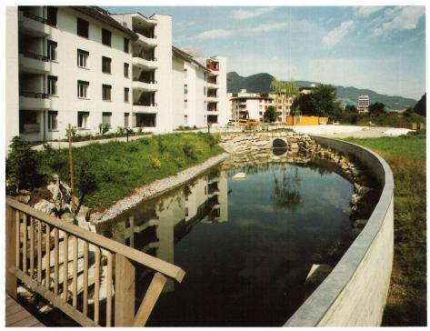
Abb. 2: Durch CAD-Einsatz erweitert sich das Aufgabenfeld des Ingenieurbüros allgemein um Dienstleistungen im Rahmen langfristiger kommunaler Konzepte. Im Bild: Retensionsbecken für Regenwasserzufall zur Regulierung von Abflussspitzen in der Gemeinde Stans, ein weiteres Projekt der Desserich + Partner AG.
