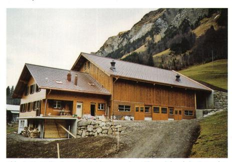
Abb. 9: Die Vollendung des Rohbaus vor dem Wintereinbruch im Dezember 2000 ermöglicht viel Eigenleistung im Innenausbau (Foto: P. Tschümperlin, kant. Meliorationsamt SZ).
