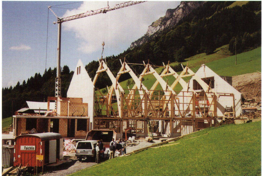
Abb. 8: Kurz vor dem Aufrichten der Scheune im September 2000. Die Schneelast und der Lawinenschutz erfordern eine massive Konstruktion (Foto: P. Klaus, ASV/BLW).
