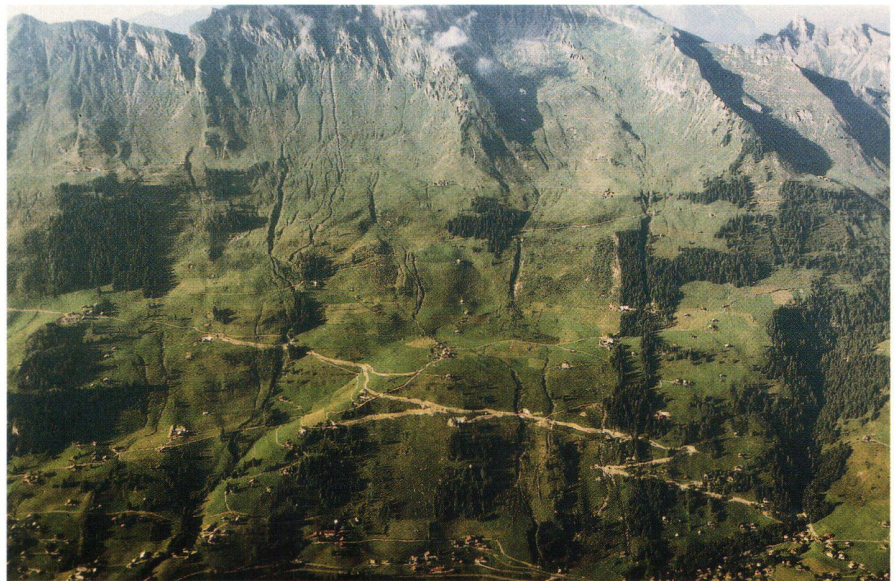
Fig. 5: Le chemin de base (les aménagements ne sont pas terminés) donne accès aux bâtiments, près de fauche, forêts et zones d'estivage (photo: Bureau Duchoud-Haymoz-Bühlmann à Aigle).
