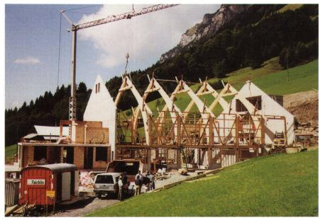
Abb. 8: Kurz vor dem Aufrichten der Scheune im September 2000. Die Schneelast und der Lawinenschutz erfordern eine massive Konstruktion (Foto: P. Klaus, ASV/BLW).
