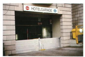
Abb. 2: Dammbalkenlösung zum Schutz einer Tiefgarageneinfahrt.
