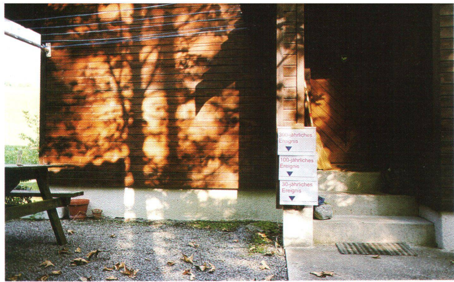
Abb. 1: Überschwemmungskoten an einem Gebäude.
