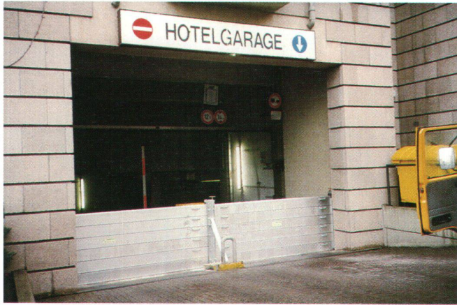
Abb. 2: Dammbalkenlösung zum Schutz einer Tiefgarage-einfahrt.
