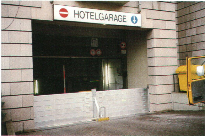
Abb. 2: Dammbalkenlösung zum Schutz einer Tiefgarageneinfahrt.
