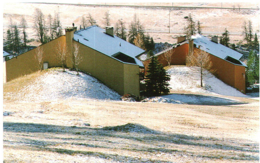
Abb. 4: Lawinenschutzmassnahmen an Gebäuden in Pontresina.
