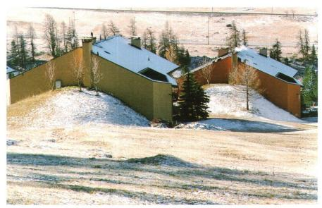
Abb. 4: Lawinenschutzmassnahmen an Gebäuden in Pontresina.
