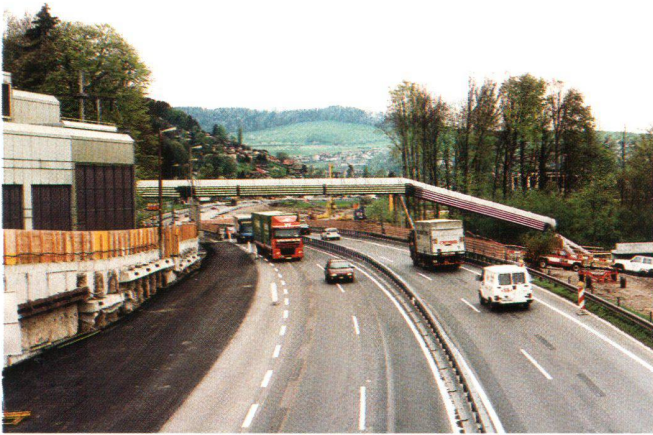
Abb. 5: Vorbereitungsphase: Umleitung von Werkleitungen und Bächen.
