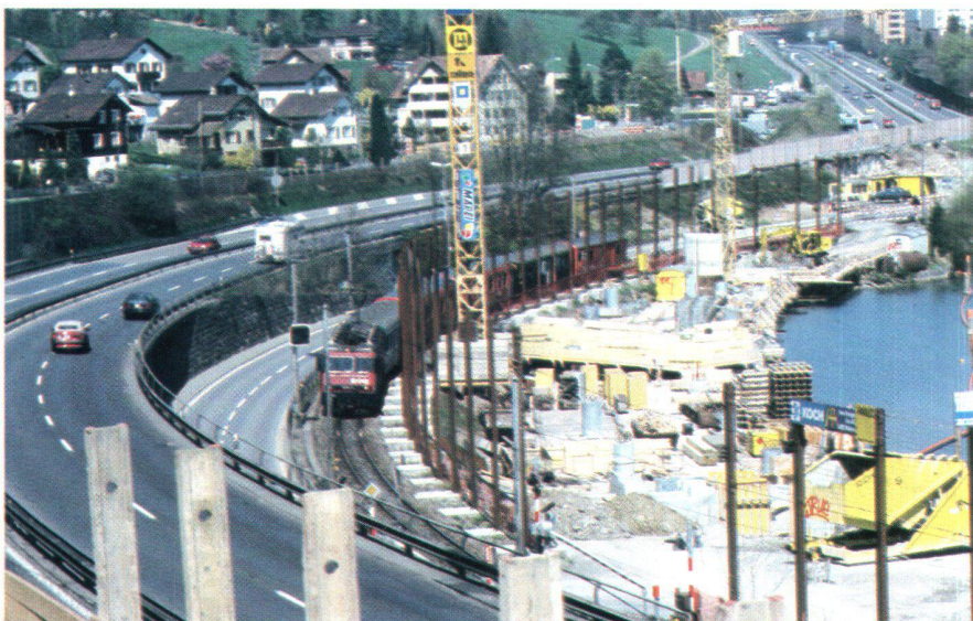
Abb. 4: Bahnbrücke (im Bau).
