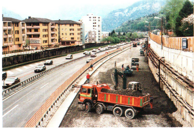
Abb. 6: Verkehrsprovisorien: Vorbereitung von provisorischen Fahrspuren.
