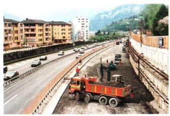
Abb. 6: Verkehrsprovisorien: Vorbereitung von provisorischen Fahrspuren.
