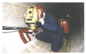
Abb. 9: Vortriebskontrolle im Pressrohr Ø 1,25 m.
